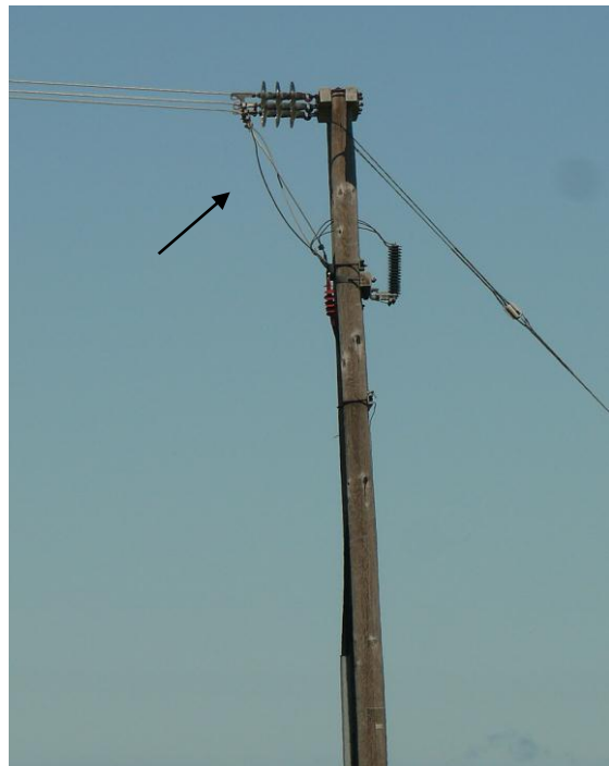
Figure 3. À gauche : Sous-station électrique où se côtoient des éléments sous tension potentiellement dangereux pour les oiseaux. Les modifications pourraient inclure l'isolation des câbles qui pendent verticalement et davantage d'espace entre les pièces sous tension. À droite : Pylône d'extrémité de ligne électrique ; les câbles de liaison (flèche) placés sous les conducteurs et les isolateurs font plus de 60 cm de long, offrant un perchoir au sommet du pylône (Photos : Bureau Waardenburg).
