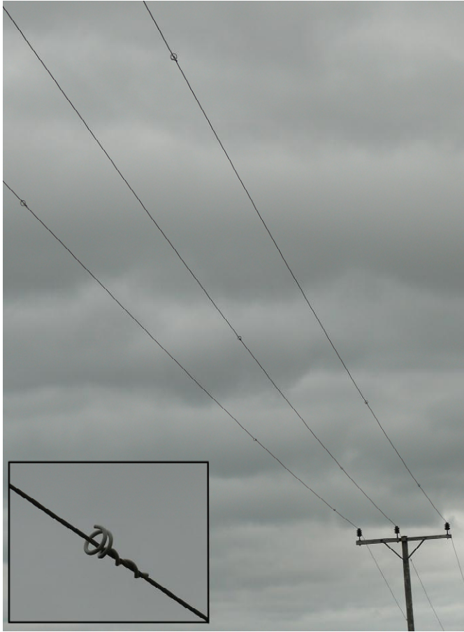
Figure 19. Ligne moyenne tension avec petites spirales (aussi appelées « queues de cochon ») placées à intervalles réguliers sur le conducteur comme dérouteurs de vol d'oiseaux (Photo : Bureau Waardenburg).
