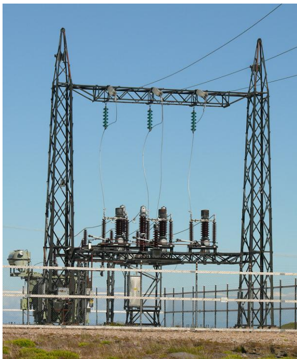
Figure 3. À gauche : Sous-station électrique où se côtoient des éléments sous tension potentiellement dangereux pour les oiseaux. Les modifications pourraient inclure l'isolation des câbles qui pendent verticalement et davantage d'espace entre les pièces sous tension. À droite : Pylône d'extrémité de ligne électrique ; les câbles de liaison (flèche) placés sous les conducteurs et les isolateurs font plus de 60 cm de long, offrant un perchoir au sommet du pylône (Photos : Bureau Waardenburg).
