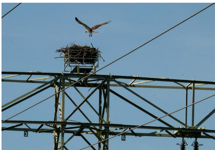
Figure 15. Nidification d'un balbuzard pêcheur sur une plateforme artificielle de ligne moyenne tension, parc national de Muritz, Allemagne (Photo; Bureau Waardenburg).
